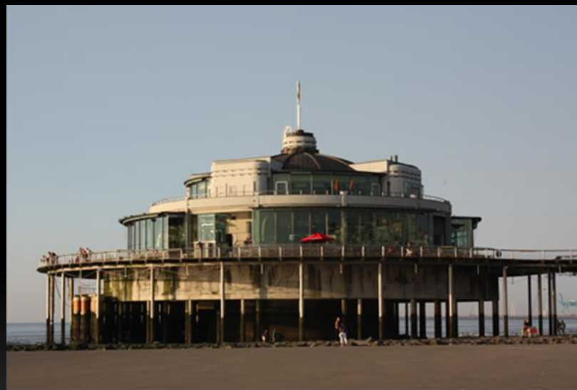
1998-2003 De pier blankenberge (arch groep planning)
