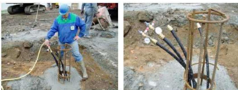
Remplissage à l'eau, et mise en pression des tubes
