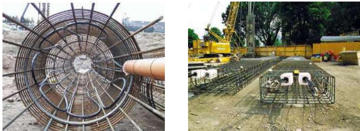
Figuur 5a : a) Wapeningskorven voorzien met slangen (bron : [www.zent-frenger.de](http://www.zent-frenger.de)) geboorde/schroefpalen en b) Wapeningskorf met slangen voor panelen (brone : Stent – Balfour Beatty) (COFOGE 2007)
