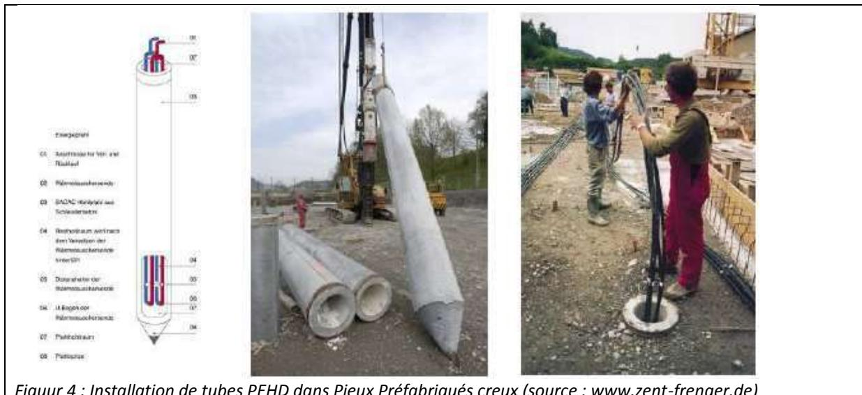
Figuur 4 : Installation de tubes PEHD dans Pieux Préfabriqués creux (source : [www.zent-frenger.de](http://www.zent-frenger.de))
